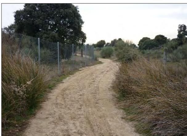
Poco a poco, el camino se va estrechando según avanzamos. En este punto tenemos 4,80 metros entre cercas. La arena del firme y los juncos de las cunetas indican que estamos en una zona llana (donde se deposita la arena erosionada por el agua) y húmeda (como denota la flora predominante).
