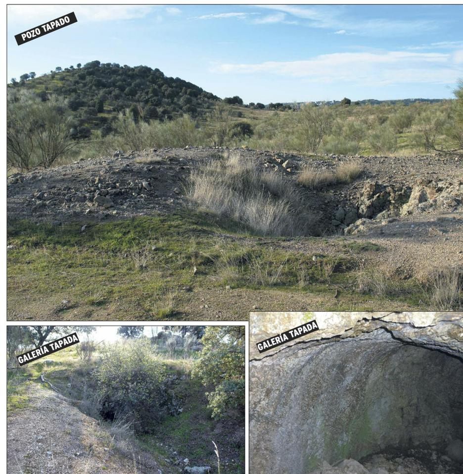
explotación consta de un pequeño pozo de 10 metros de profundidad comunicado por una pequeña galería de dos metros con un socavón —rampa de 1,5 metros situado en el centro de una pequeña escombrera. Esta entrada se encuentra parcialmente aterrada y llena de basura.
